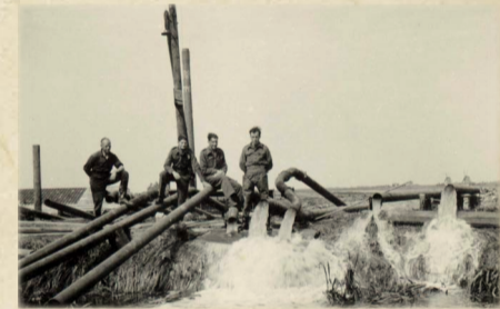
Het water wordt uit de polder in de Ringvaart gepompt
