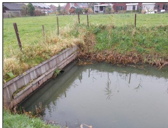
Figuur 7. Beschoeiing watergang bij opgangen plangebied.
