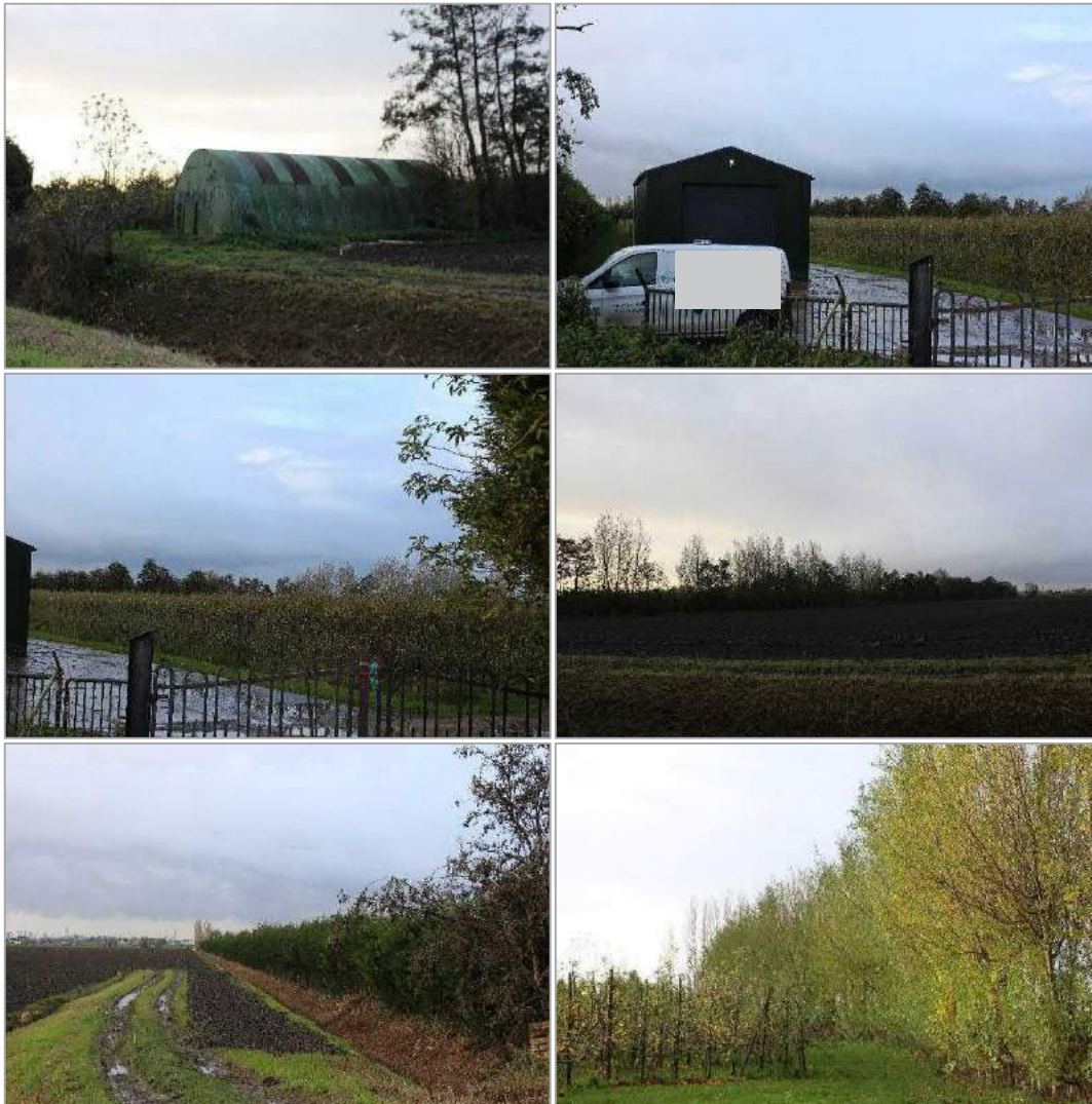
Figuur 3.2 Impressie van het plangebied waar het nieuwe hoogspanningsstation komt.
