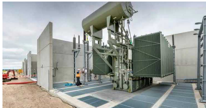
Transformator in betonnen ombouw
