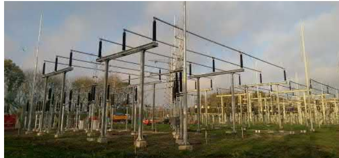
Schakeltuin met bliksempieken met grint of gras ondergrond
