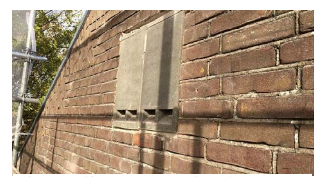
Vleermuisverblijven opgenomen in de gevel
