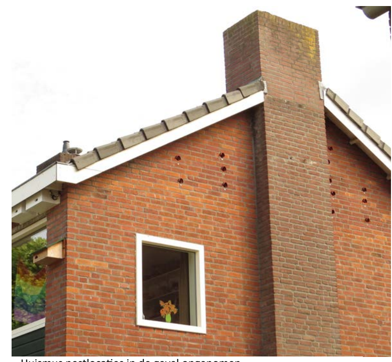
Huismus nestlocaties in de gevel opgenomen
